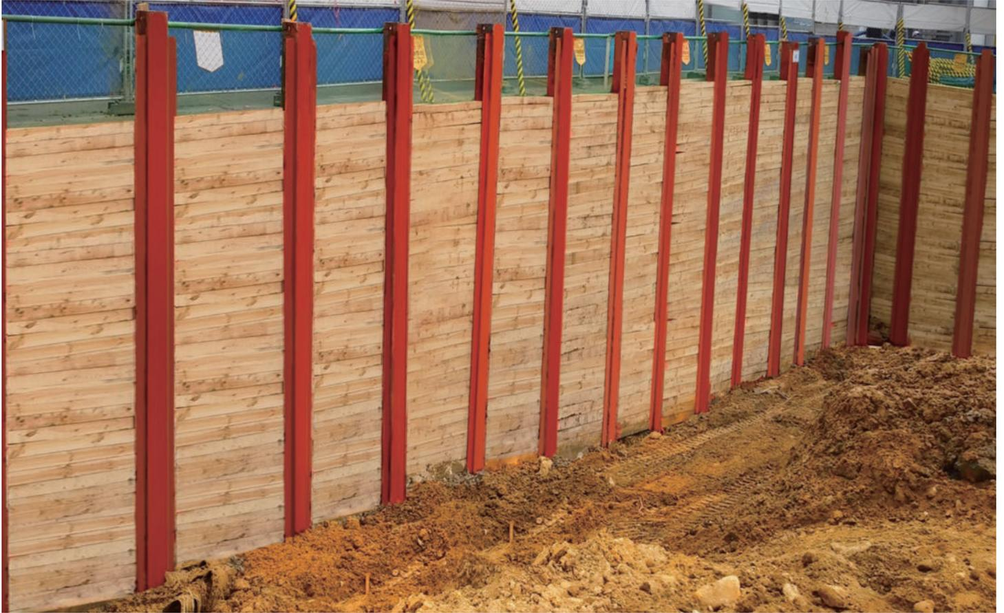
**P.F.C.D.A 자립식 흙막이 가시설**은 사각 각관 속에 콘크리트 및 몰탈 충전 (21MPa이상)으로 **사전 응력**을 적용시켜 **빔 강성** 자체만으로 가시설의 안정성을 증대시키고, 분리식 정착구를 사용하여 흠 내 변위를 방지한 공법
