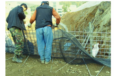
3. 철망패널 및 보조철망 설치
