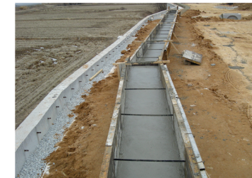
2. 기초거푸집 설치 및 콘트리트 타설
