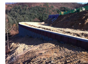
6. 3~5번 반복 후 마감블럭 설치
