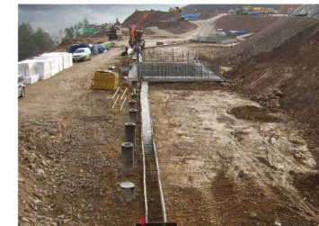
2. 기초거푸집 설치 및 콘크리트 타설
