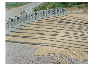
3. 블럭 및 그리드 설치
