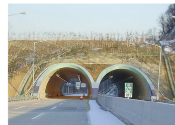
청원 - 상주간 고속도로 7공구
