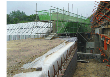
2. 성형틀 및 거푸집 설치
