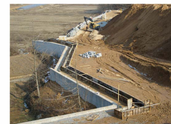
2. 기초거푸집 조립 및 기초 콘크리트 타설
