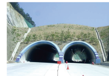
청원 - 상주간 고속도로 7공구
